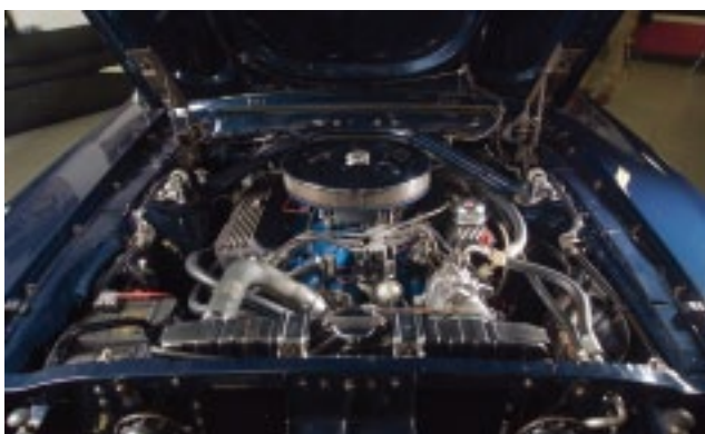
Die fertig eingebaute Feuerlöschanlage ist kaum sichtbar im Motorraum. Der Veteranen-Status soll damit gewahrt werden.
